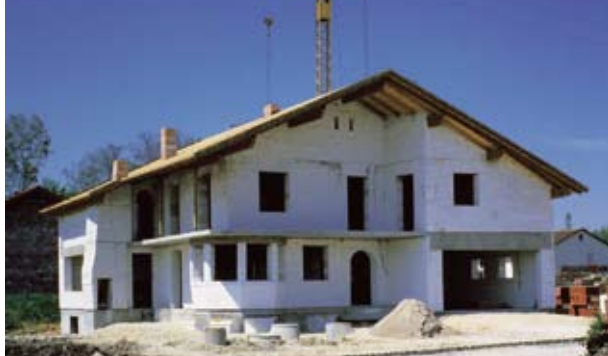
Construction en béton cellulaire
