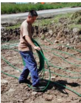
Pose de capteurs horizontaux
