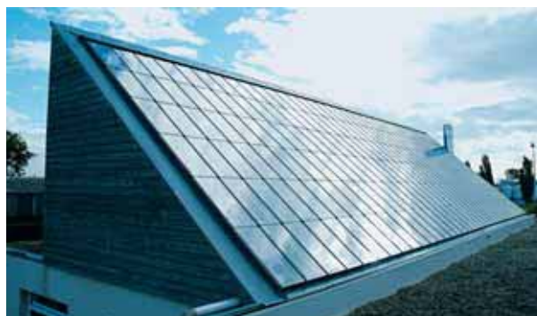
Les maîtres d'ouvrage publics montrent de plus en plus un réel intérêt pour le bâtiment basse énergie. Un exemple ici, avec l'utilisation de capteurs solaires thermiques sur le toit de la piscine d'Ungersheim en Alsace.
